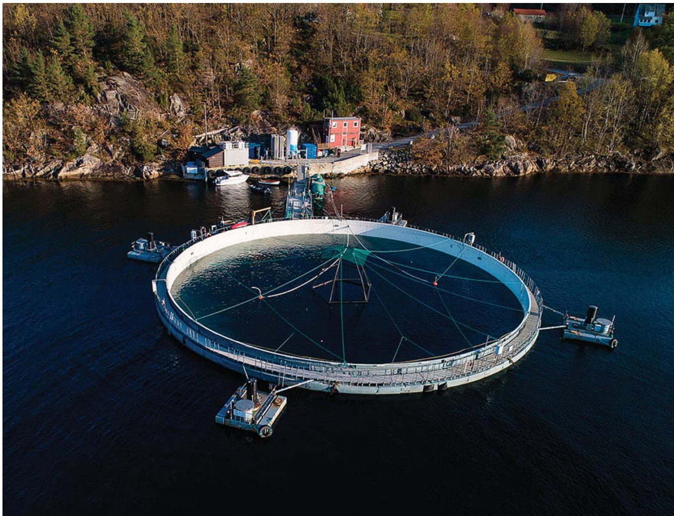
LUKKET ANLEGG: Testprosjekt med lukket merd ved Molnes nær Skånevik i Sunnhordland. Merden fra Aquaform Equipment kan på det meste romme en million laks opp til en kilo. FOTO: MAGNE LANGÅKER/AQUAFARM
